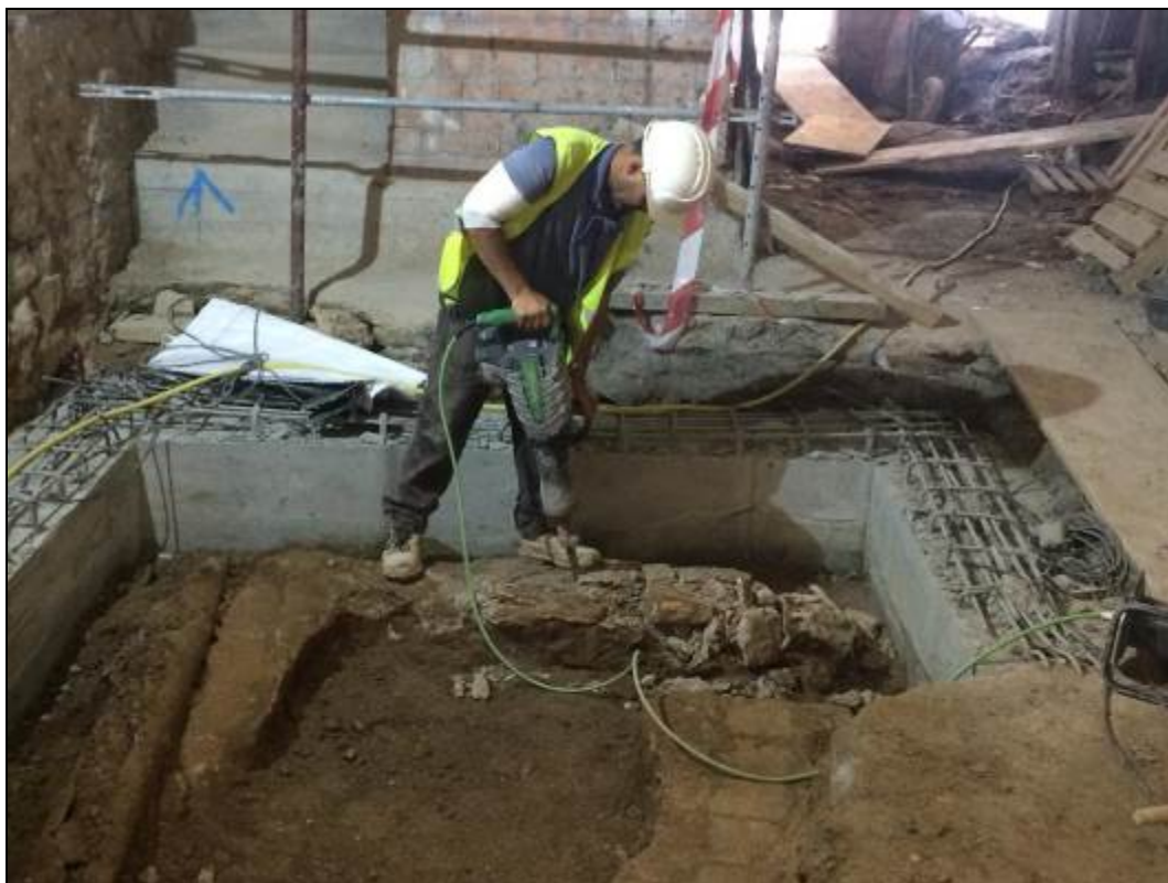
Fotografia 20. Demolició de les estructures d'època contemporània.
