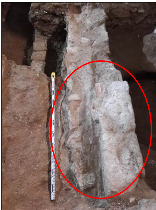
Fotografia 13. Detall del mur UE1003. En aquesta fotografia marquen l'àrea afectada.
