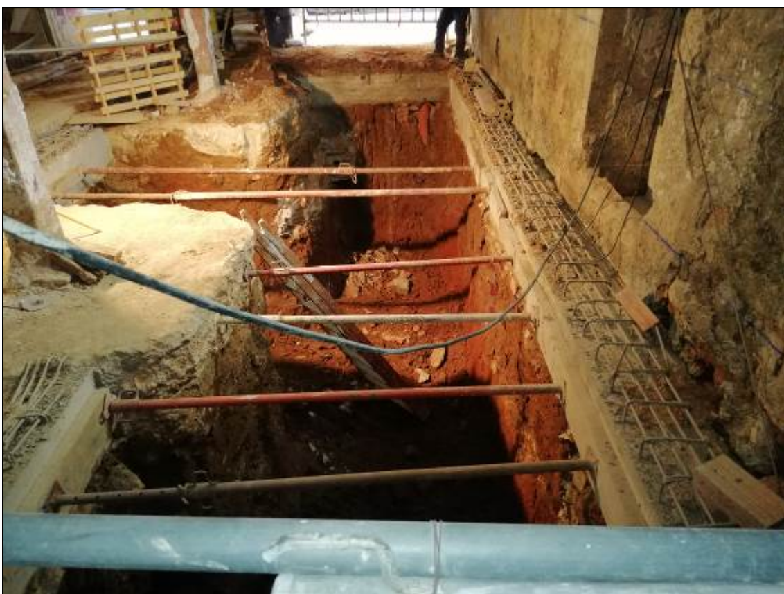
Fotografia 24. La cala un cop es finalitzaren les feines d'excavació amb màquina.
