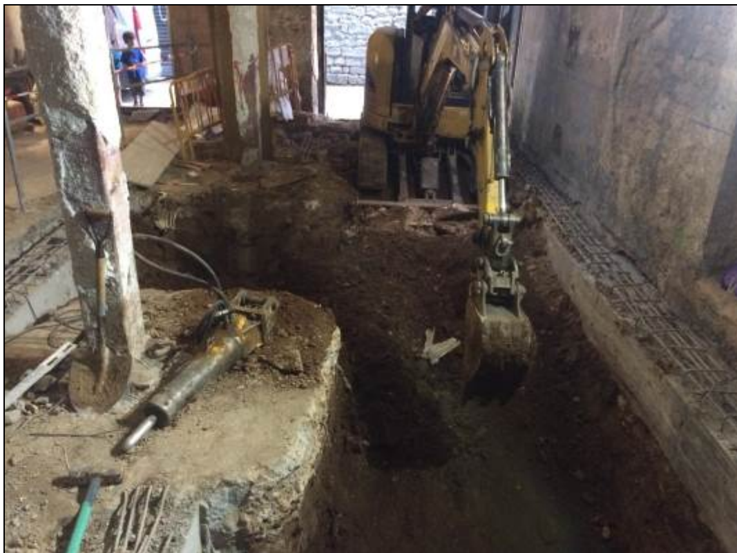
Fotografia 21. Rebaix de terres un cop eliminades les estructures d'època contemporània.
