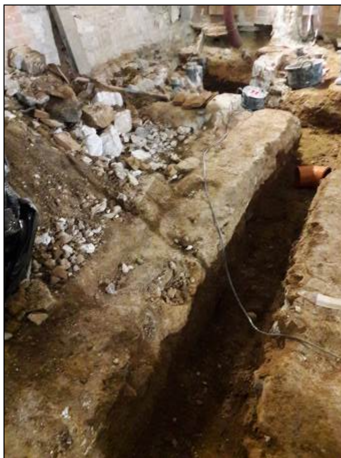
Fotografia 8. Detall de la rasa de servei que es va dur a terme durant els treballs.
