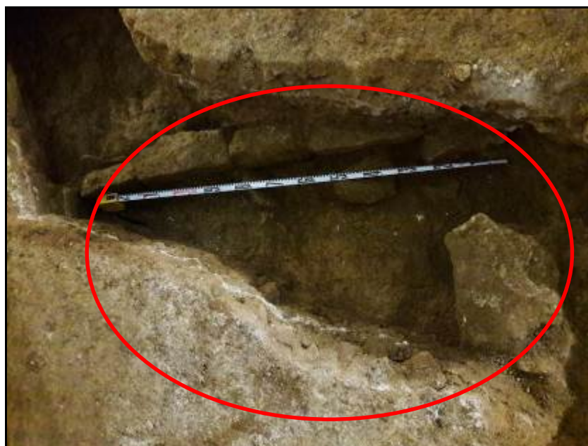
Fotografia 12. Detall del dipòsit UE1030. La línia vermella marca el grau d'afectació.
