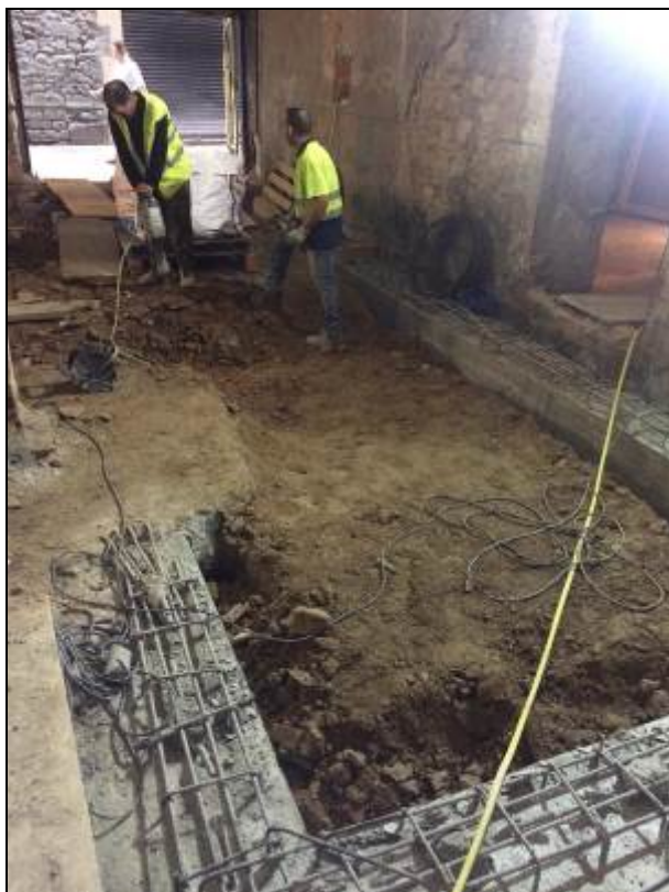
Fotografia 16. Inici dels rebaixos.
